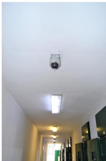
Telecamera n°70 isolamento lato A
